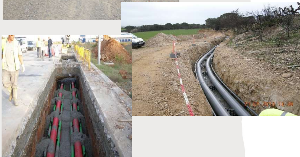
Ejemplos obras similares realizadas
