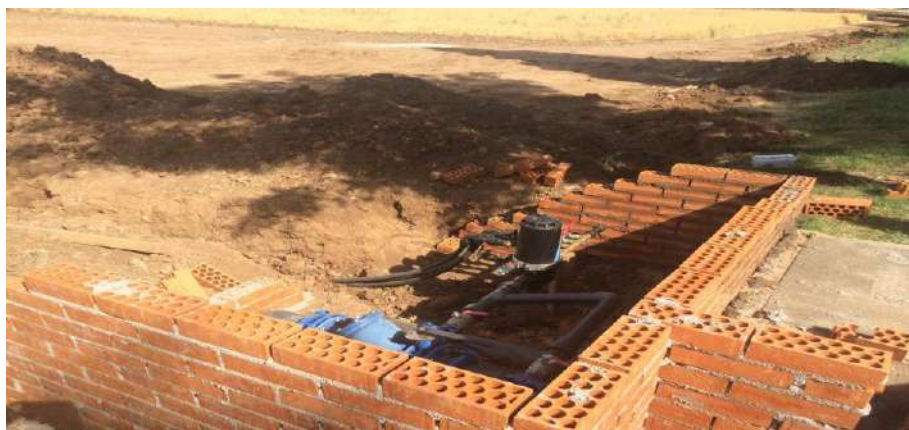
Figura 4: Acometida de riego
