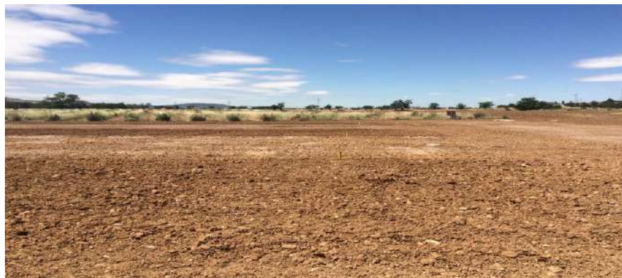
Figura 3: Labores previas a la parcelación
