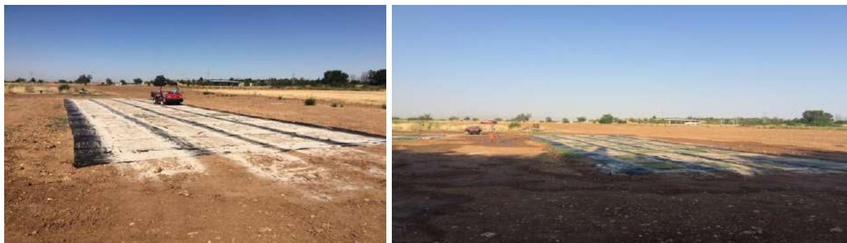
Figura 18: Labores de growing/establecimiento
