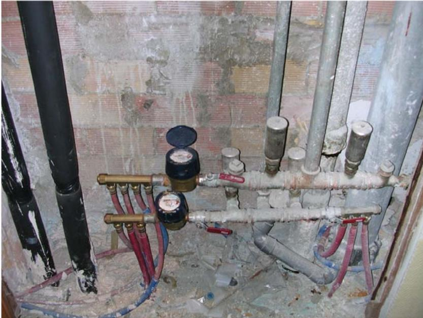
Figura 2.10. Contadores instalados en la alimentación de un núcleo húmedo
