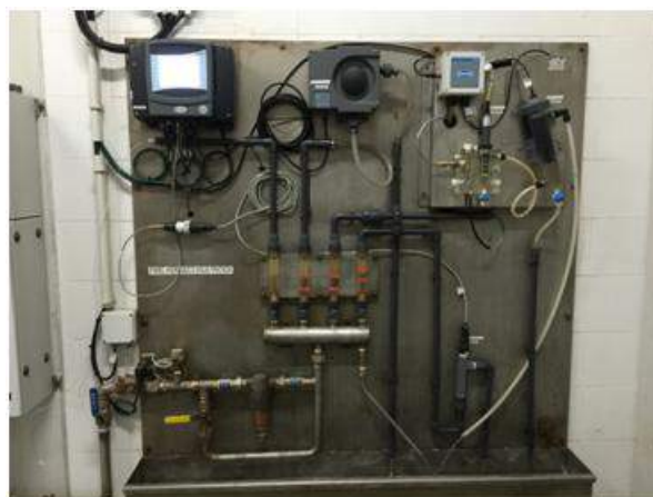
Figura 27: Panel hidráulico a la salida de la línea de filtración y de la línea de ósmosis inversa en la ERAR de Arroyo Culebro (Fuente Canal de Isabel II)
