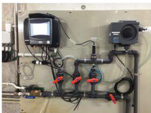
Figura 27: Panel hidráulico a la salida de la línea de filtración y de la línea de ósmosis inversa en la ERAR de Arroyo Culebro (Fuente Canal de Isabel II)
