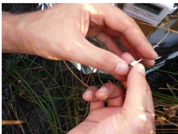
Foto 2-7: Colocación de la tuerca en la conducción.
