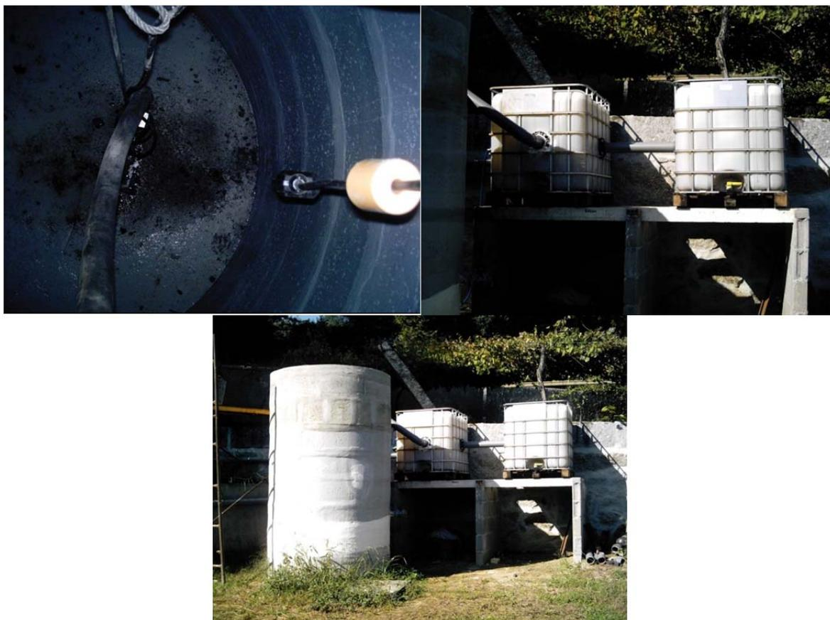
Foto 8-1: Detalle de las fosas de almacenamiento, del digestor HUSB (parcialmente soterrado), de los depósitos de decantación D1 y D2 y de los depósitos de decantación y carga al FV (D1 e D2).
